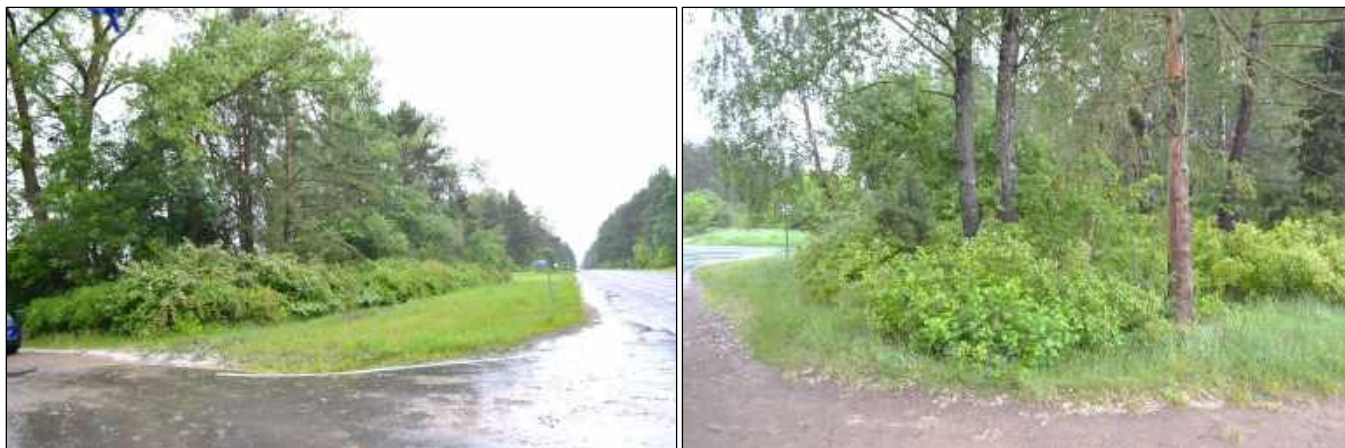
Рисунок 3.5 – Лесная растительность на участке сочленения подъездной дороги с трассой М11
