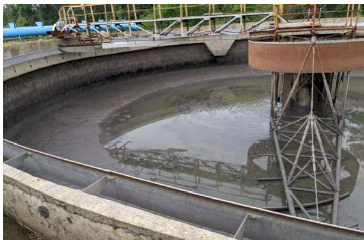
Рис.6. Первичный отстойник Лидских ОС
