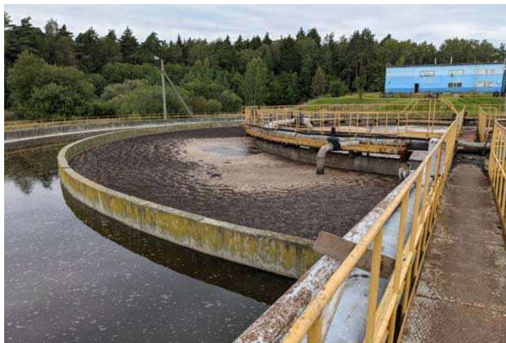
Рис.7. Биооксиблок Лидских ОС
