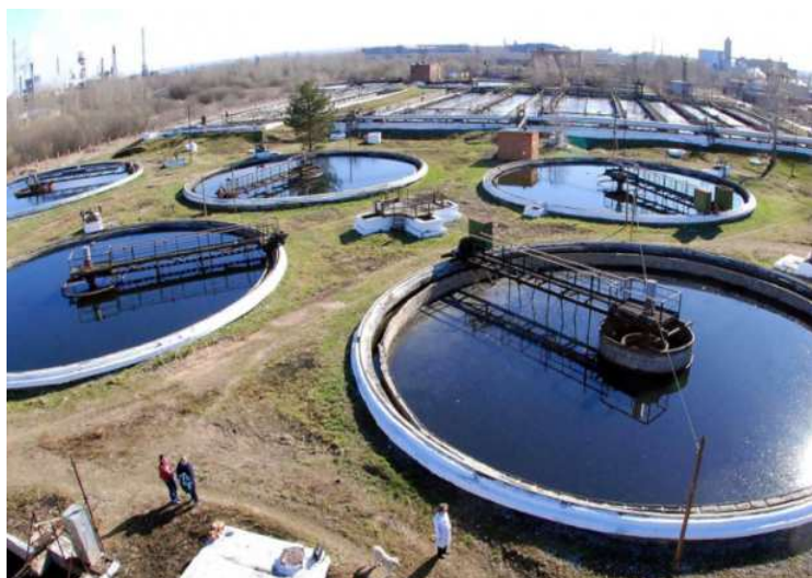
Рис.4. Производственная площадка городских очистных сооружений
