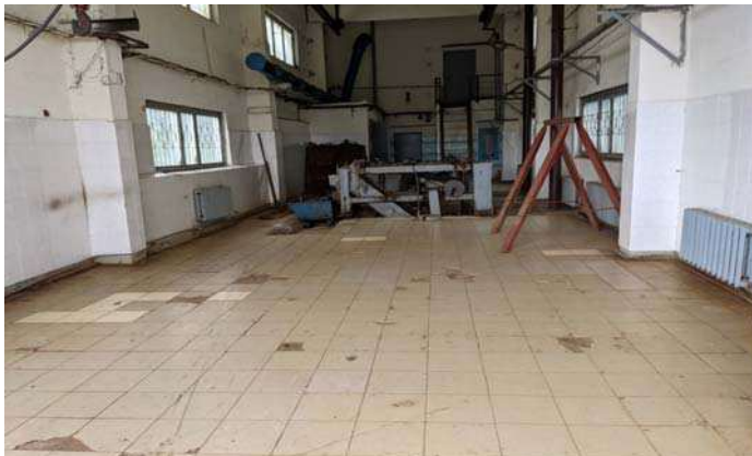
Рис. 5. Здание решеток Лидских ОС
