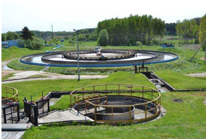
Рис. 1 Канализационные очистные сооружения г.Лида
